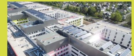
Préchauffage de l'eau chaude sanitaire (ECS) par des installations solaires, sur chaque bâtiment. Au total, 1 000 m<sup>2</sup> de capteurs thermiques assurent la production de 40 % de l'ECS.
